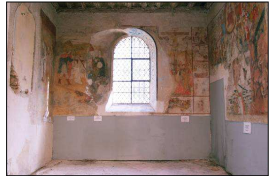
Chapelle sud pendant la restauration (2010)
