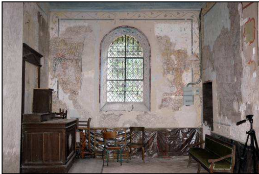
Chapelle sud avant la restauration (2004)
